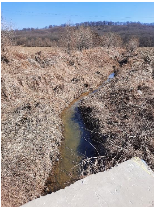
Foto 1.1. Canal în zona de intersecție DN2-A8
