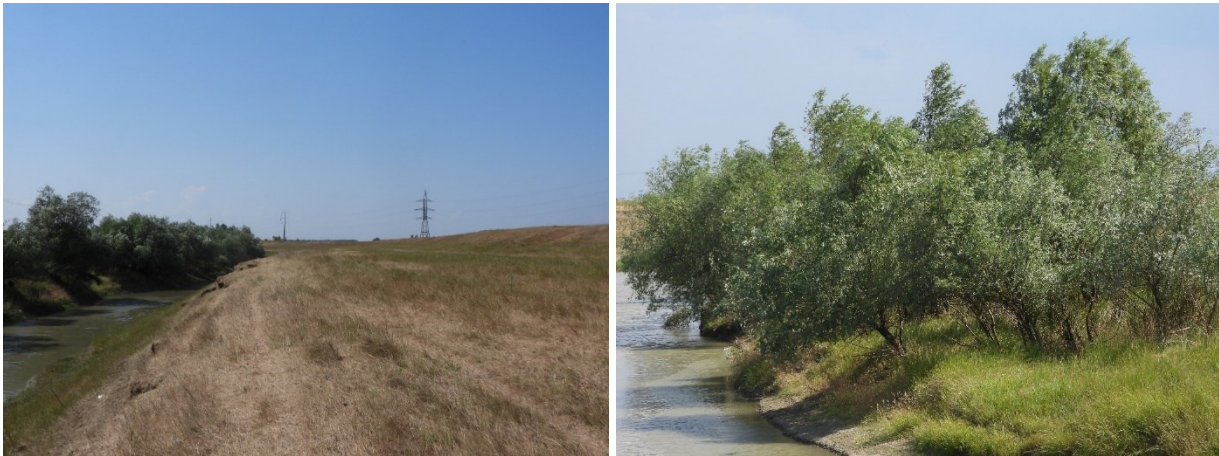
Foto XIII.49. Aspect de la nivelul amplasamentului cu habitatul R4416
