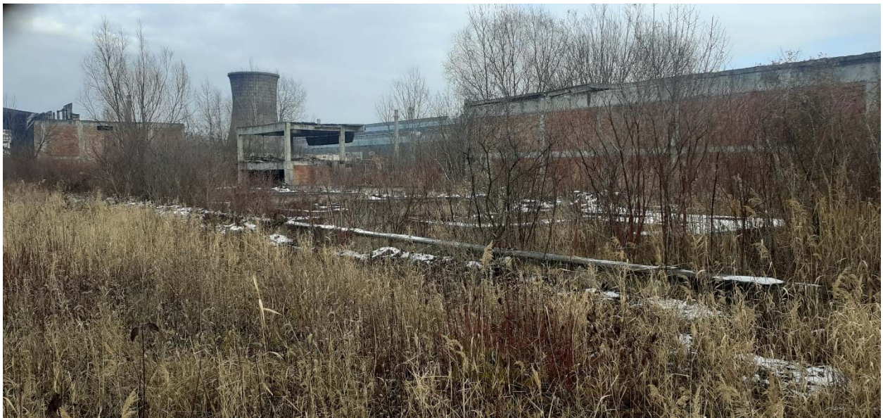
Fig. 2 Constructii demolate partial in afara ariei in care se va construi
