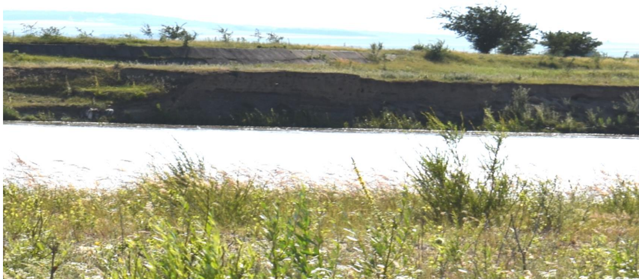
Figura 10: Eroziune mal drept râu Moldova în dreptul perimetrului La Păstrăvărie
