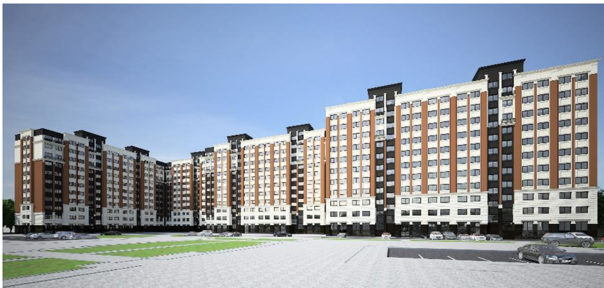
Aspect general al proiectului
