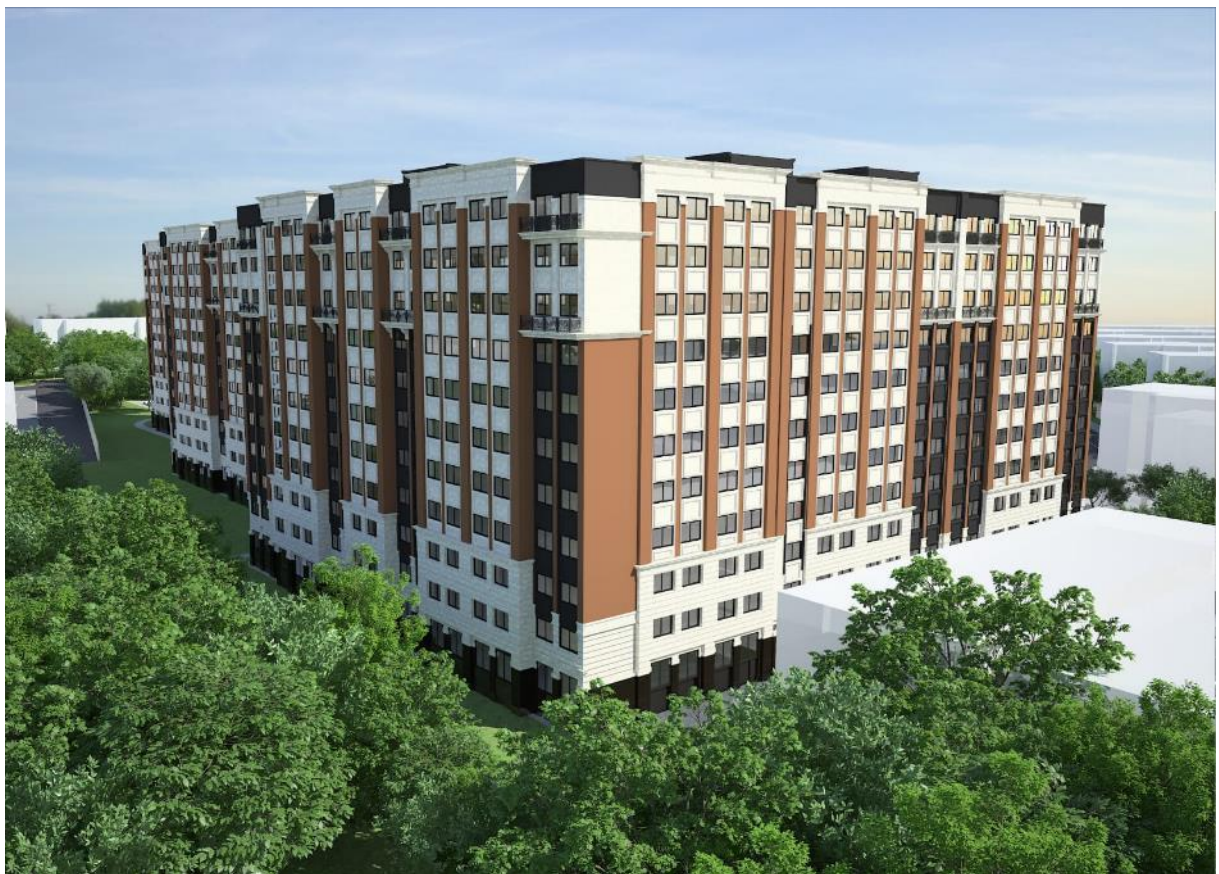
Aspect general al proiectului
