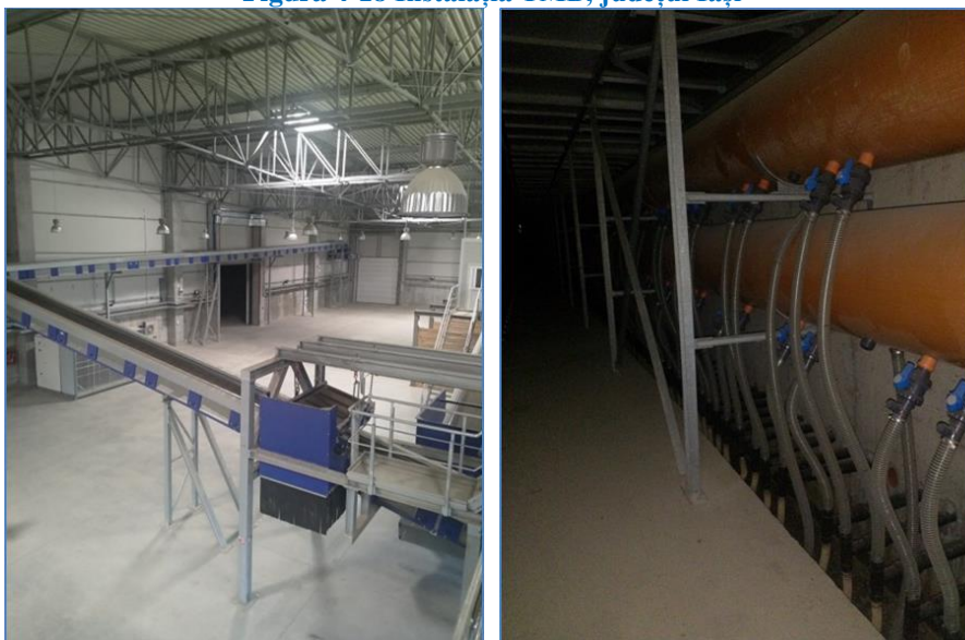
Figura 4-18 Instalația TMB, județul Iași
