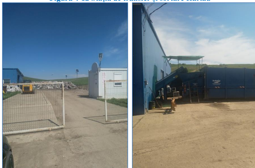
Figura 4-12 Stația de transfer și sortare Hârlău
