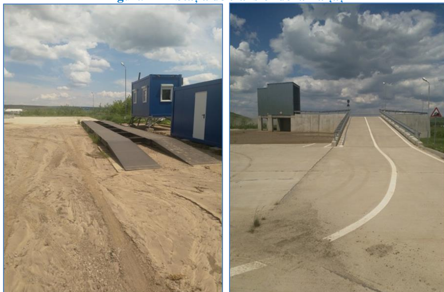
Figura 4-11 Stația de transfer de la Bălțați
