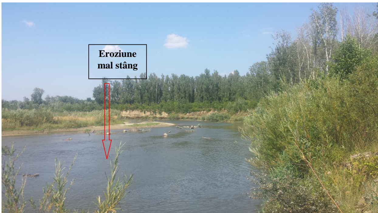
Eroziunea malului stâng opus perimetrului “HĂLĂUCEȘTI AVAL”
