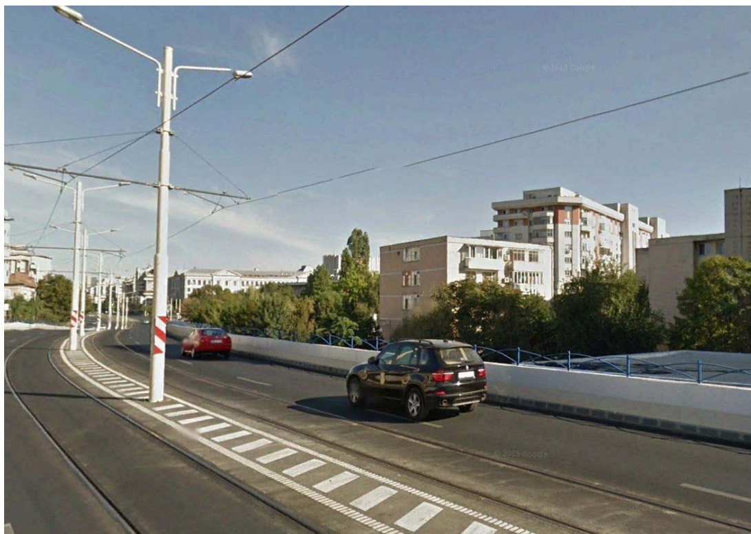
Figura 108: Pasaj rutier cu infrastructură de tramvai. Exemplificare din municipiul Craiova
