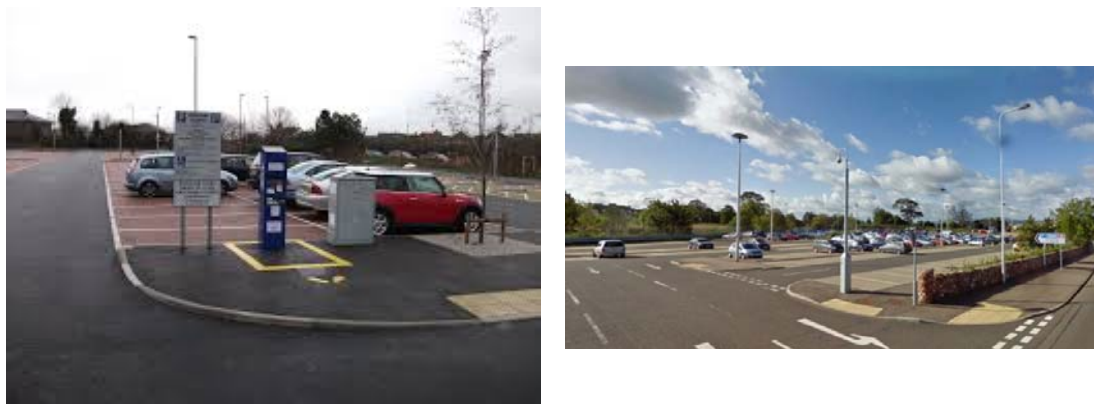
Figura 142: Exemple de amenajare de Park&Ride (dimensiuni medii) în Marea Britanie (sursa: Google Earth)
