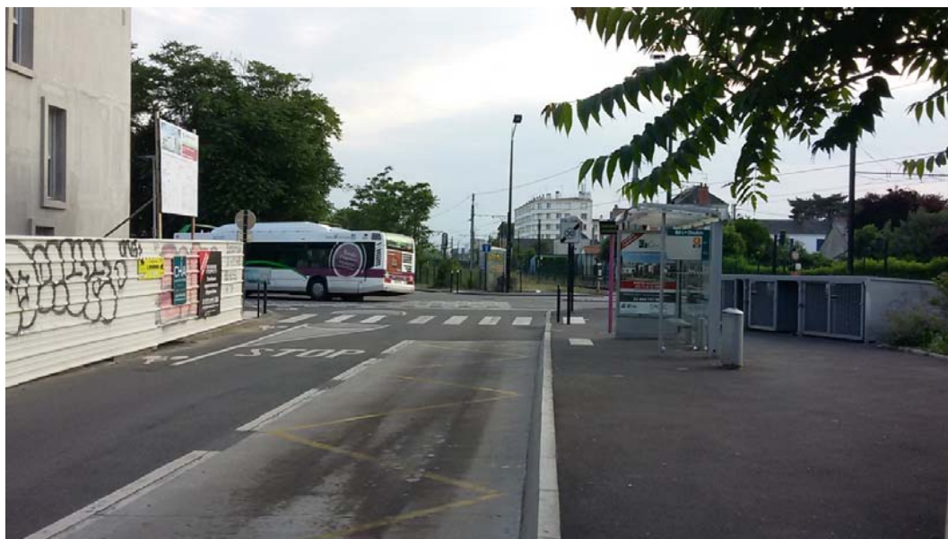
Figura 123: Stație amenajată cu marcaje pentru prioritizarea autobuzelor. Nantes. Franța
