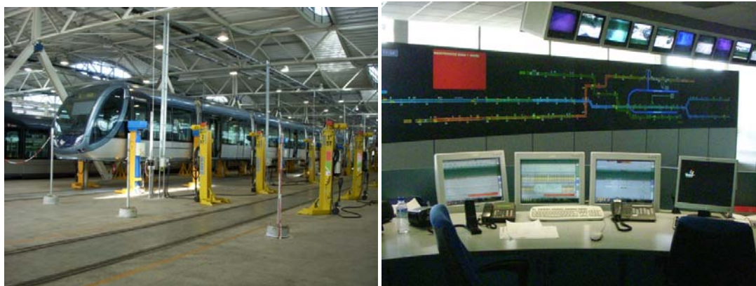
Figura 110: Exemplu de facilități moderne într-un depou cu ateliere de întreținere și Centru de control în Bordeaux, Franța (Sursa: TTK)
