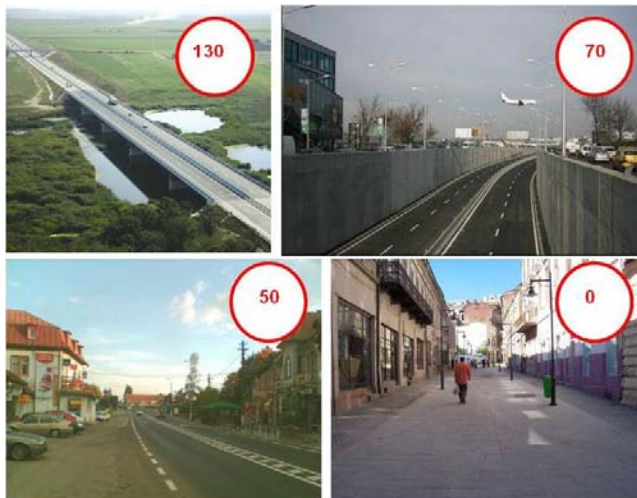
Figura 2: Exemple de drumuri lizibile (Sursă: Manual de siguranță rutieră pentru Rep. Moldova. Administrația de Stat a Drumurilor, 2011)
