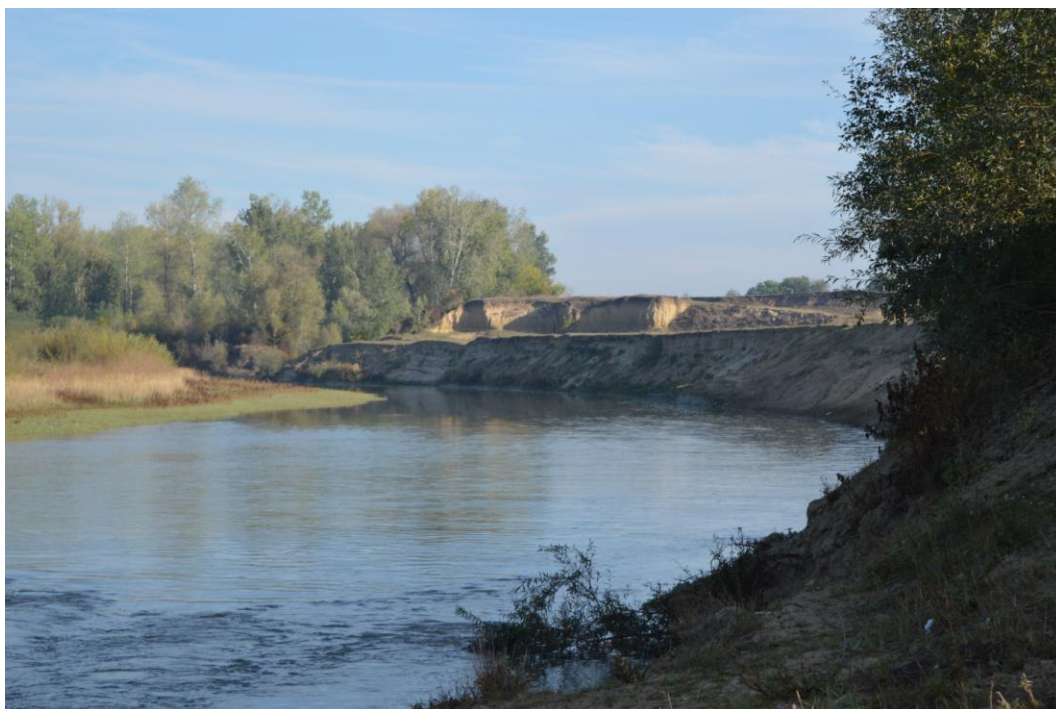
Eroziune mal stâng ca urmare a acumulării de aluviuni pe malul drept în perimetrul Șcheia 1 –zona amonte
