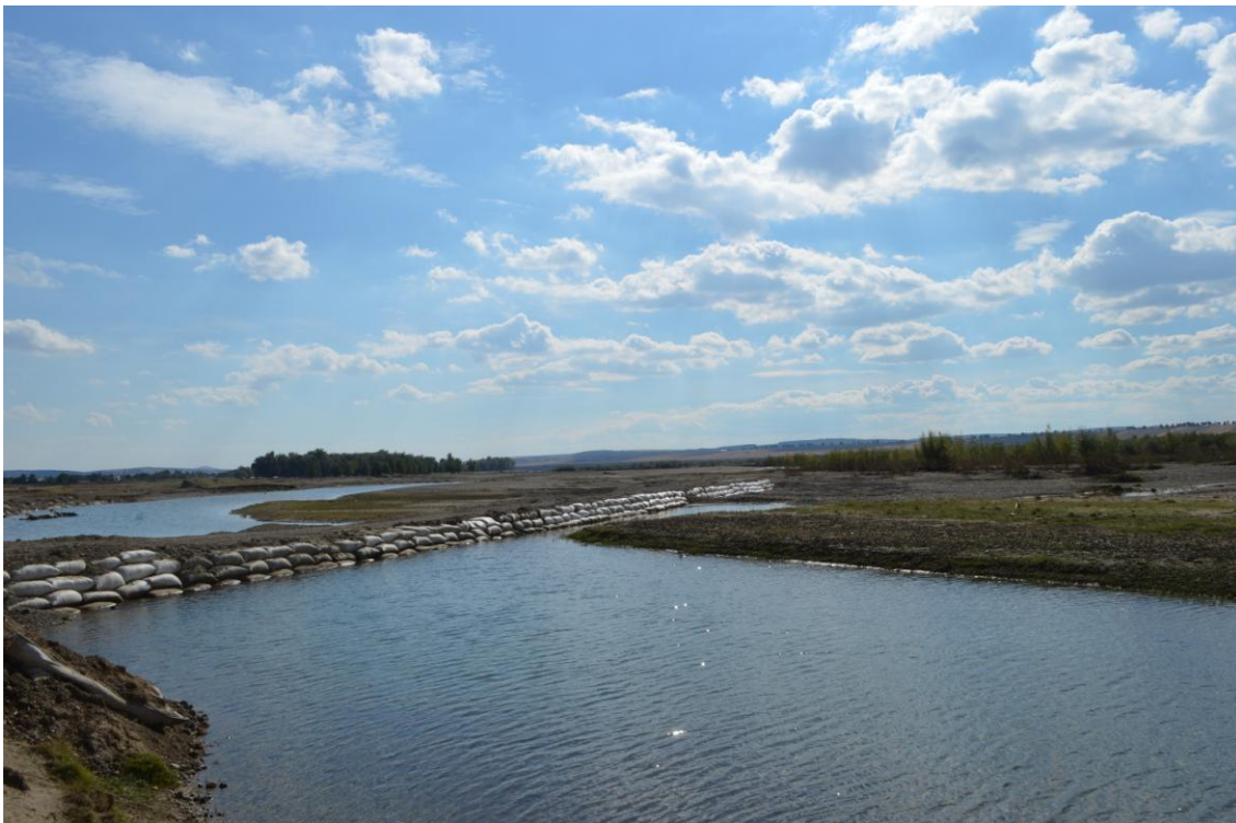
Aspecte ale conservării nefavorabile ale habitatelor din zona proiectului – eroziune, inundație
